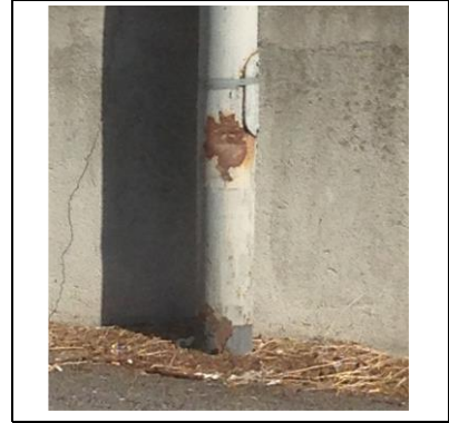
Sostegno ammalorato
