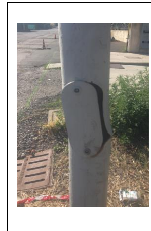
Sostegno ammaccato
