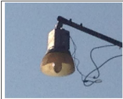
CL stradale con lampada HG
